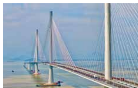
黄茅海跨海通道
