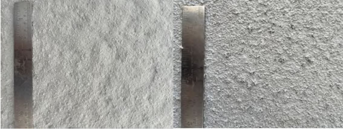
图3 老人牌保温隔热漆170喷涂后形成的良好均匀漆面和质量欠佳且粗糙的漆面示例。
