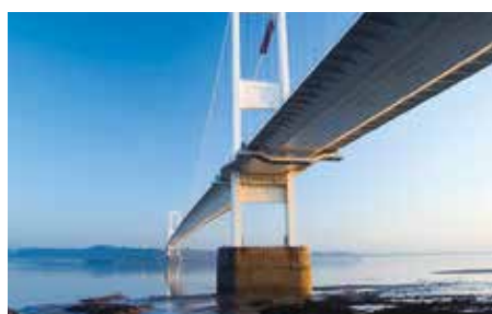
舟山西堠门大桥
