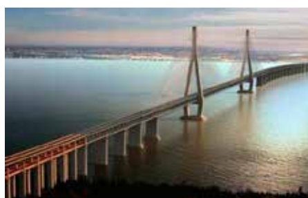
沪通长江大桥
