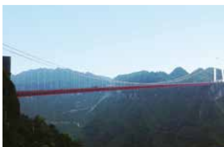
湖南矮寨大桥
